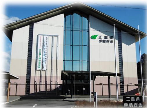
実行委員会事務局が設置される 三重県 伊勢庁舎
